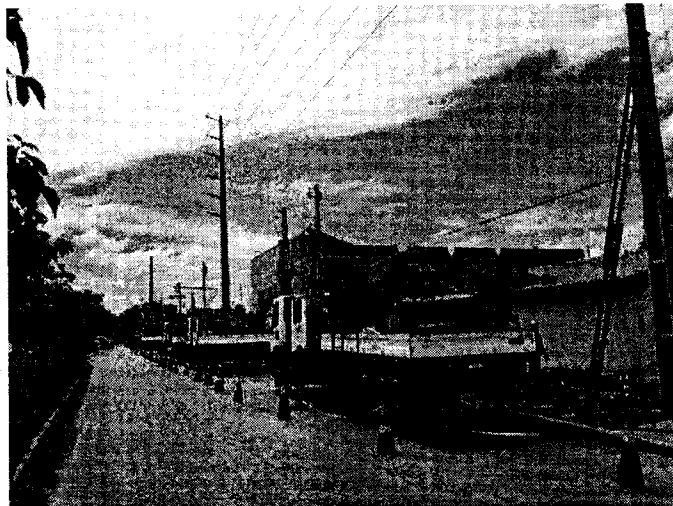
Equipes da Equatorial Maranhão realizam serviços para melhorias na rede elétrica
